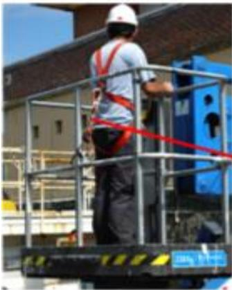
Eslinga ajustable, se consigue una restricción y un posicionamiento de trabajo.
